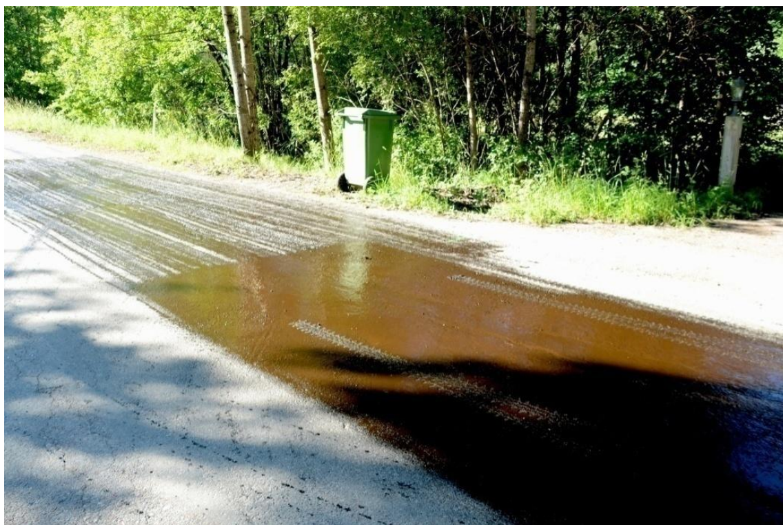
Figur 3-1 Försöket delades upp i tre olika sektioner på 10 m vardera. En delyta applicerades med mycket klister, en delyta med lite klister, och en delyta lämnades helt klisterfri. (Foto: Tomas Åström, 2011)
