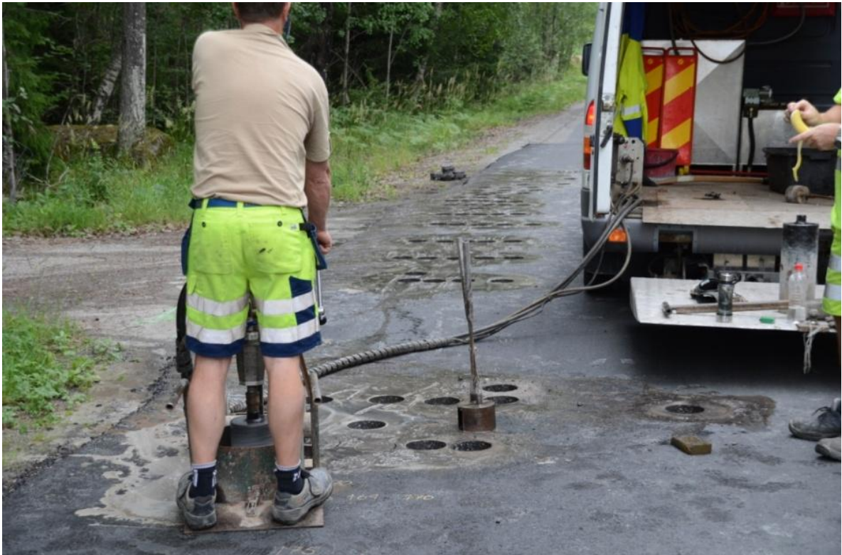
Figur 3-5 Totalt 165 borkärnor med en nominell diameter på 150 mm togs upp från Gamla Stäketvägen. (Foto: Tomas Åström, 2011)
