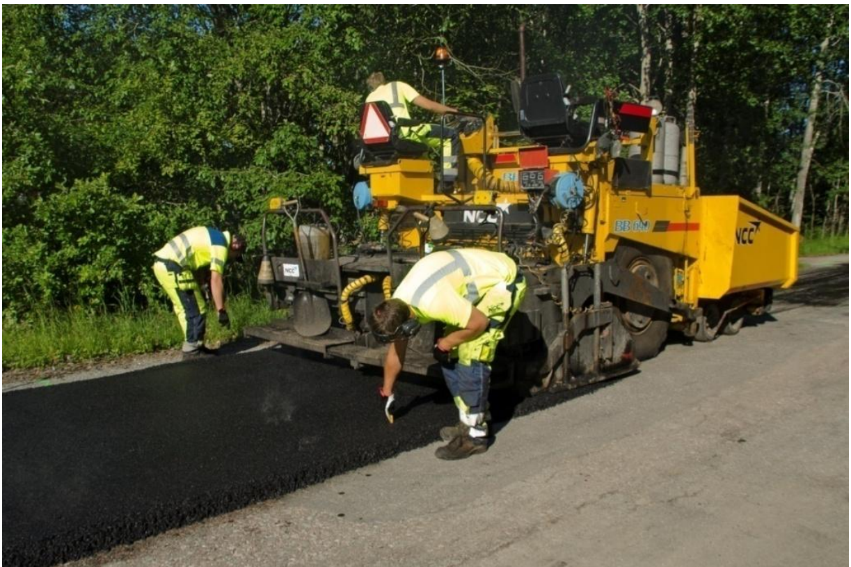
Figur 3-3 Efter utförd klustring packades en 30 meter lång sträcka med en c:a 40 mm tjock ABT16. (Foto: Tomas Åström, 2011)
